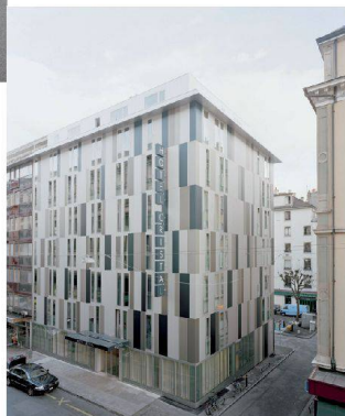
<Die Fassade aus Aluminiumpaneelen überspielt den strengen Raster der Fenster.
