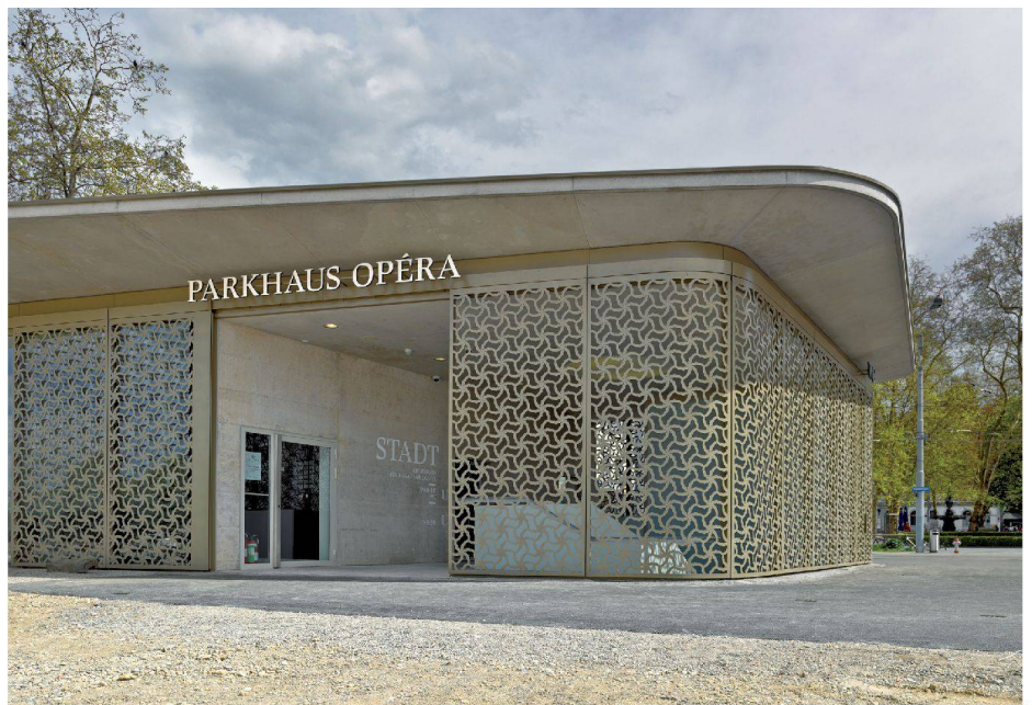
^ Der Eingangspavillon des Parkhauses Opéra gibt einen Vorgeschmack auf den künftigen Sechseläutenplatz in Zürich.
