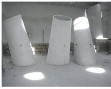
^Dach und Deckenuntersicht der Reformierten Kirche in Dornach sind unterschiedlich gefaltet — die Zylinder der Oberlichter entsprechend unterschiedlich lang.
