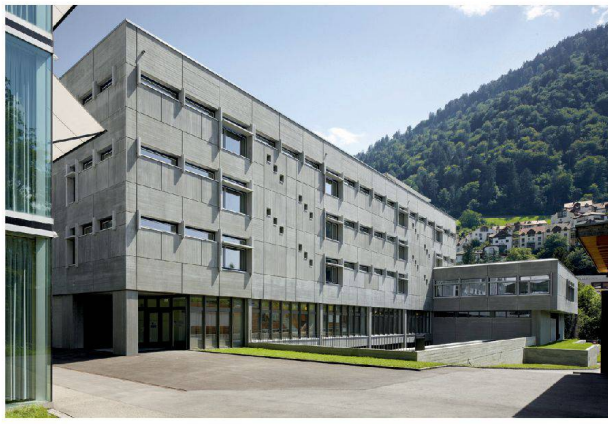
^Die Schalungsbretter der neuen Fassadenelemente übernehmen die Struktur des Originals.
