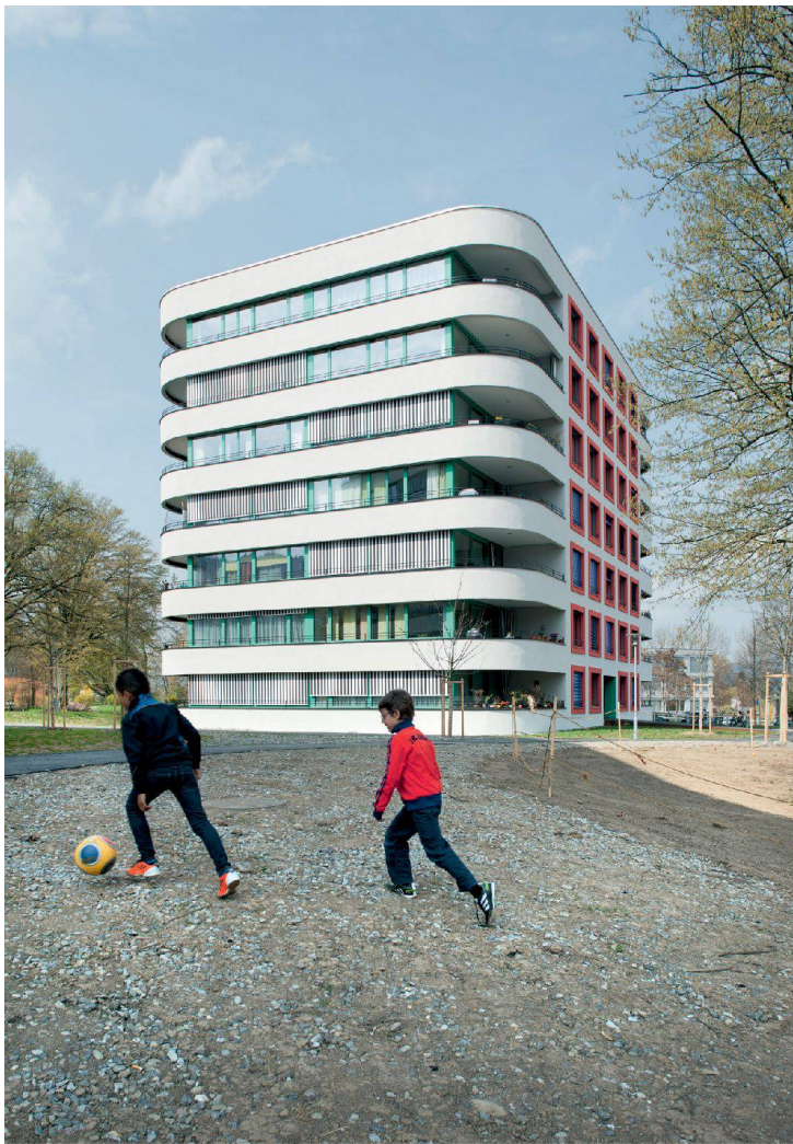
^Wohntanker vor Anker: Sieben Geschosse läuten eine neue Ära in der Siedlung ein.
