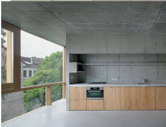
^Küchenzeilen und Bäder wurden grossteils in Ortbeton ausgeführt.
