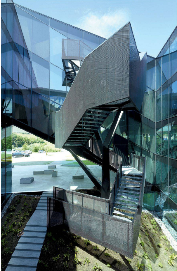
^ Innenhof mit Fluchttreppenhaus.
