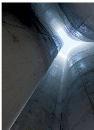
^Die organische Form verleiht der Betonkonstruktion Stabilität.
