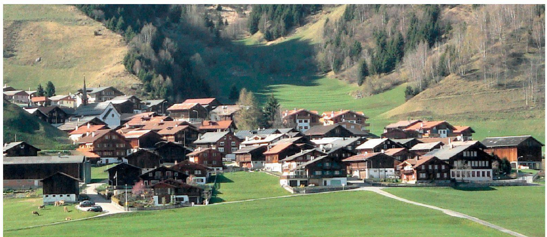
>2_Behäbige Dächer im Ortsteil Segnas.
