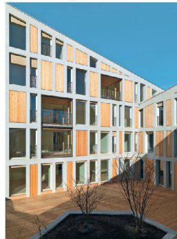
^ Nach aussen und innen verglaste Loggien unterteilen die grosszügigen Wohnräume und bilden Klimapufferzonen.
