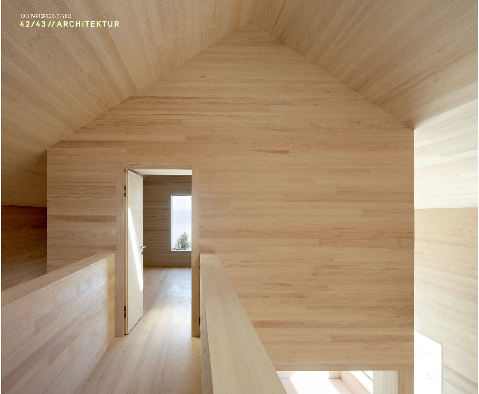
^Die perfekte Oberfläche aus astfreier Weisstanne entmaterialisiert den Raum.
