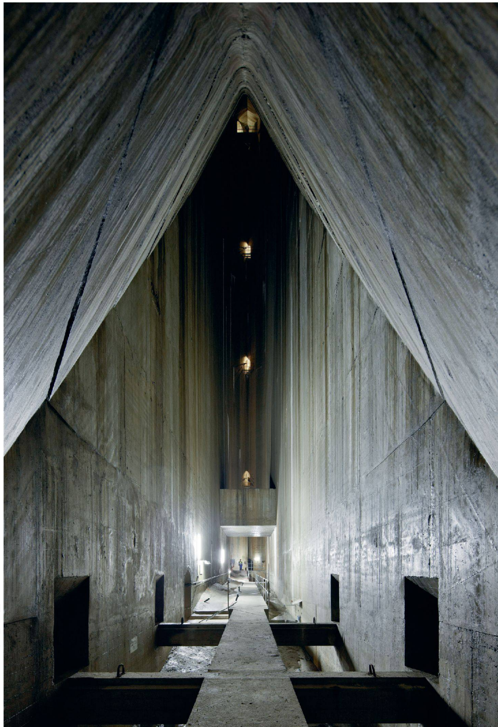
>Kathedrale des Wassers: im Innern der Albigna-Staumauer. > La cattedrale dell'acqua: All'interno della diga dell'Albigna.
