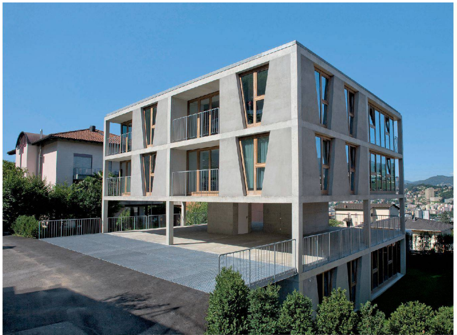
^ Der «palazzo d'appartamenti» in Pregassona zählt drei Wohngeschosse. Dazwischen ist ein Luftgeschoss eingeschoben.
