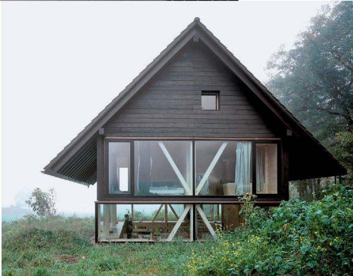
› Von aussen scheint der Neubau ein ganz gewöhnliches Haus zu sein – wenn da nicht der gläserne Sockel wäre.
