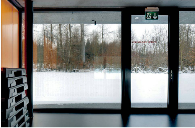
^Vogelschutzscheiben eingesetzt: Sporthalle am Waldrand in Sursee.
