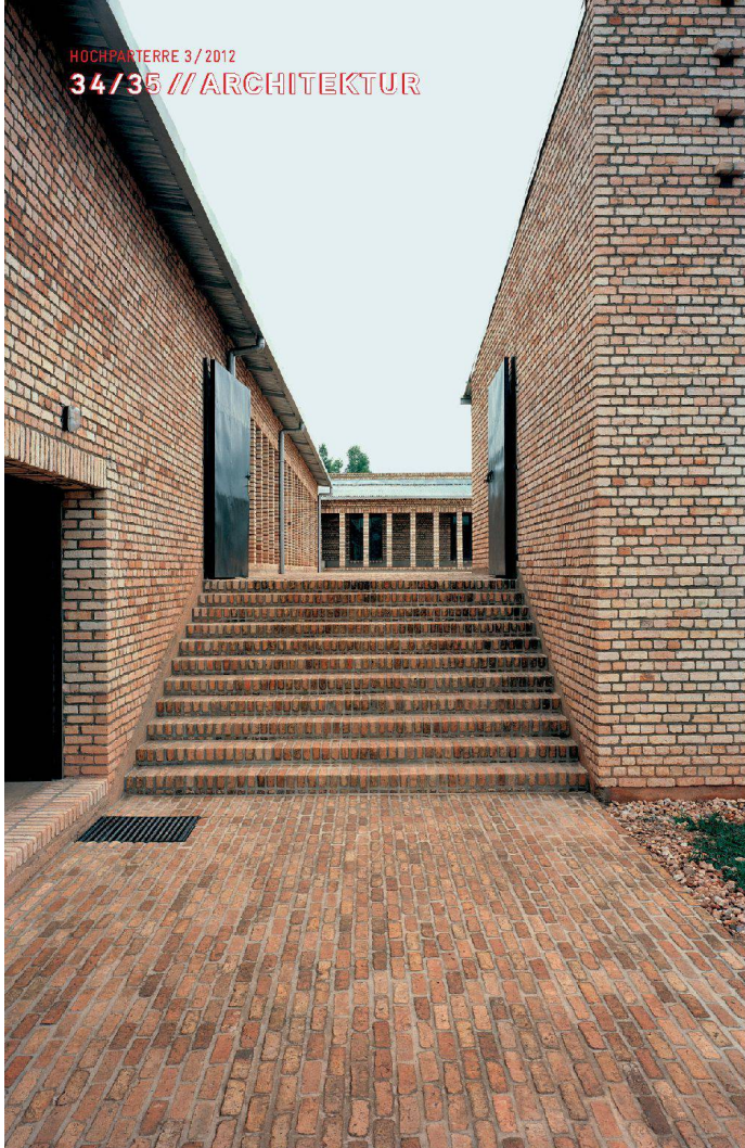
<6_Querlüftung, Lehmziegel und Flechtwerk: Bei einem Ausbildungszentrum in Ruanda schöpft der Münchner Architekt Dominikus Stark aus der Einfachheit des lokalen Bauens (2010).
