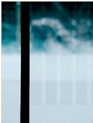
38 __ Flugverbotszone: Die streifenförmige Beschichtung warnt Vögel vor gefährlichen Scheiben. Foto: Alexander Jaquemot
