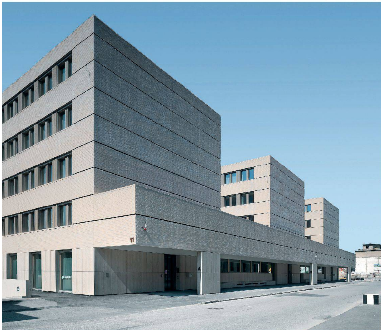
✓14_Verwaltungs- und Gerichtsgebäude Selve.
