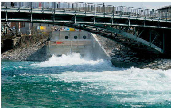
^6_Entlastungsstollen unterhalb des Kraftwerks.
