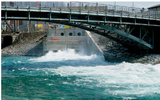
^6_Entlastungsstollen unterhalb des Kraftwerks.
