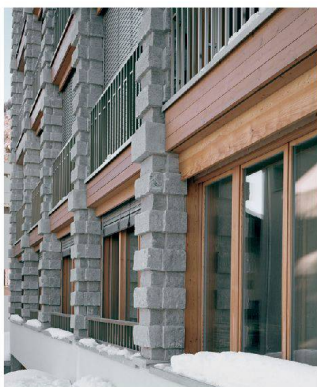
«Rustikale Kraft»: die Fassadenpfeiler der Chesa Sur.
