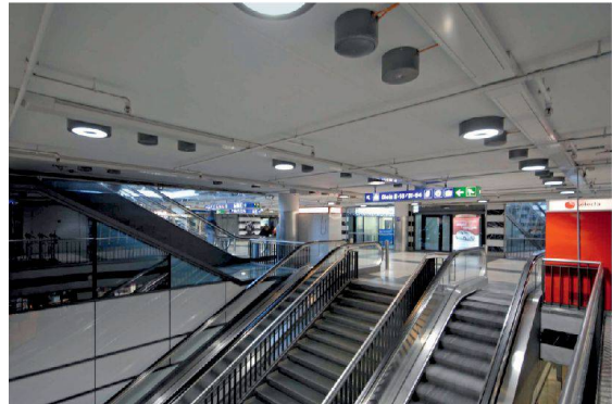
<Zwischengeschoss 2012: Die Decke ist weg, der Ort hat den Charme einer Tiefgarage.
