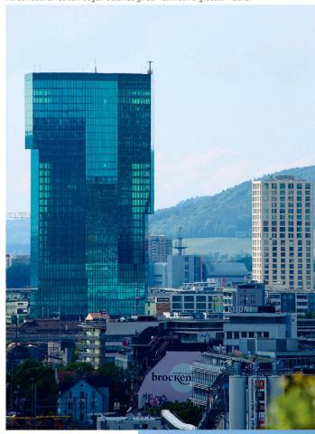
>Der Turm besetzt unten 1200 Quadratmeter und wächst um 400 Quadratmeter auf rund 1600 Quadratmeter. «Anhaltspunkte fürs Auge» nennt Annette Gigon die Auskragungen, die den Prime Tower un verwechselbar machen.
