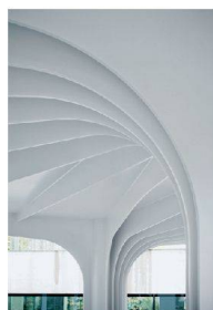
^ Stütze und Rippe fliessen nahtlos ineinander über.
