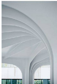
^ Stütze und Rippe fliessen nahtlos ineinander über.
