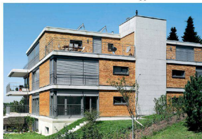
^47_Mehrfamilienhaus Obere Berneggstrasse.
