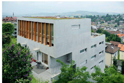
^44_Überbauung Obere Felsenstrasse.
