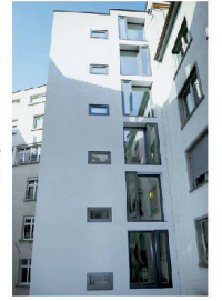
<4_Geschäftshaus Blumenbergplatz, Attikageschoss.
