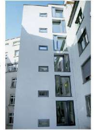
<4_Geschäftshaus Blumenbergplatz, Attikageschoss.
