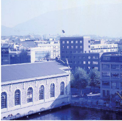
^Ein selbstbewusster Stadtbaustein.
