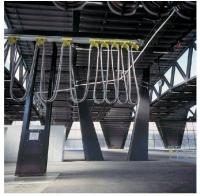
→ Stahlseile ziehen die transparenten Tore des Tramdepots in Bern nach oben. Bei Bedarf die gesamte Front.
