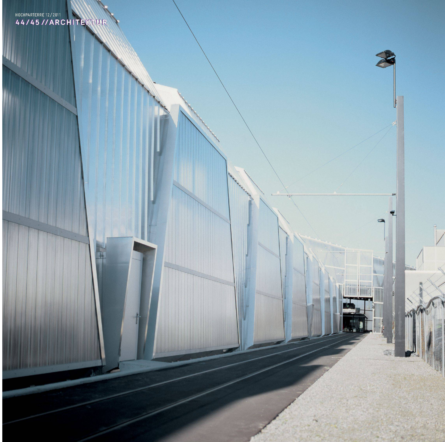
^Die schrägen Stützen sorgen für die Aussteifung der Konstruktion.
