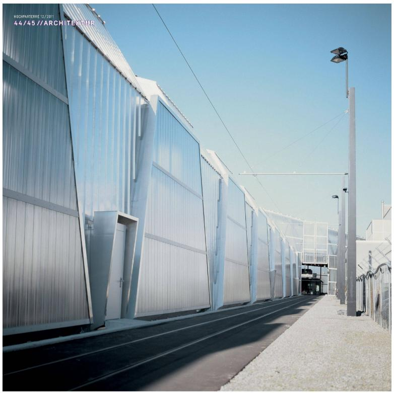
${}^{ullet}$ Die schrägen Stützen sorgen für die Aussteifung der Konstruktion.
