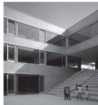
>46_Schulanlage Les Ouches.
