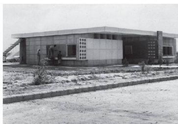
« Ab 1956 entstanden in Kirkuk, Irak, Häuser aus Fertigbeton-Elementen, die Demarmels entwickelt hatte.
