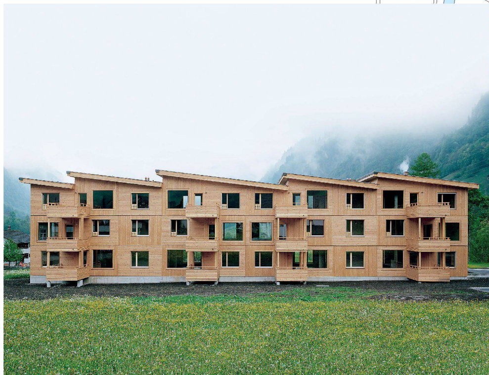
^ Sheddach, Balkontürme und die in Feldern angeordnete Schalung aus Douglasie gliedern die Südfassade.
