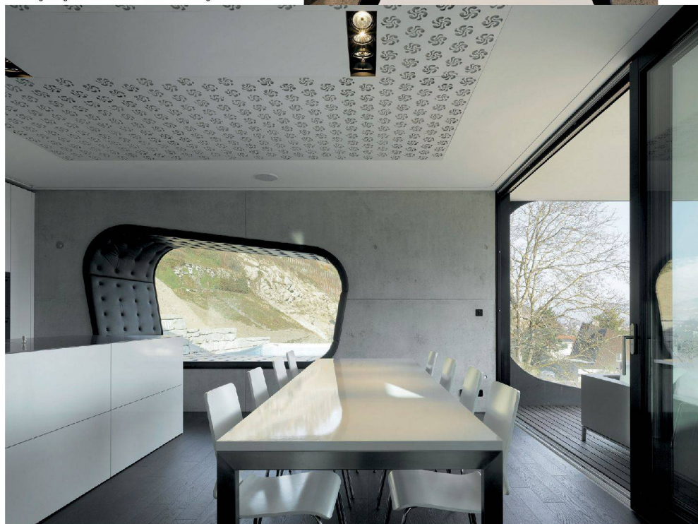
✓ Die Kautschukhaut des Wohngeschosses wird nach innen gezogen und zur Sitznische ausgebildet.
