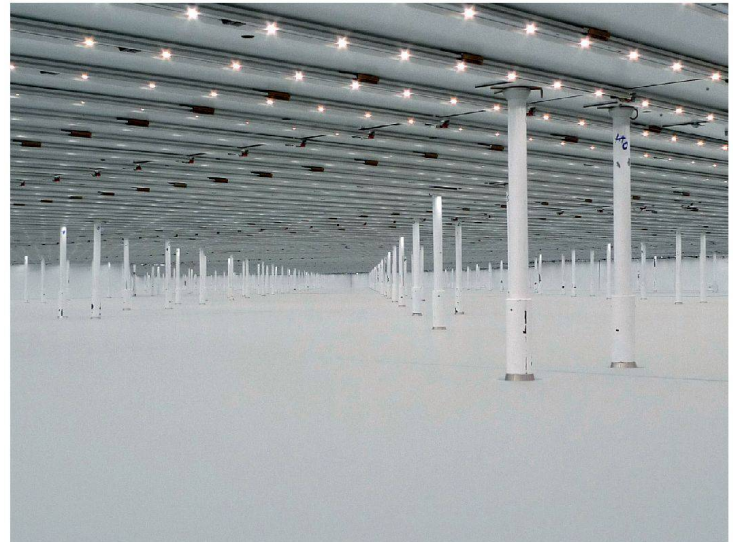
^Blick ins Konstruktionsinnere: Der scheinbar endlose, aber nur 25 Zentimeter hohe Raum zwischen LED-Paneele und Glasdecke. Foto: OAP
