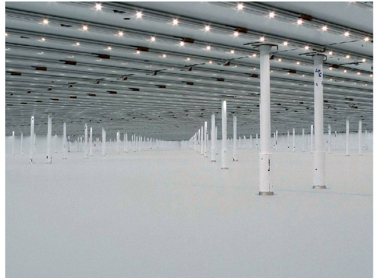
^Blick ins Konstruktionsinnere: Der scheinbar endlose, aber nur 25 Zentimeter hohe Raum zwischen LED-Paneelen und Glasdecke. Foto: OAP
