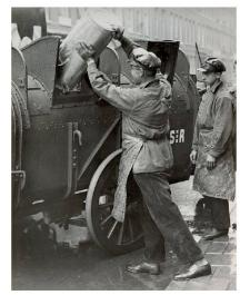
^Der Kehrichtmann hakte den Klappdeckel des ursprünglichen Ochsler-Kübels beim Wagen ein, damit sich dieser automatisch öffnete und entleerte.
