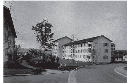
^2_Die abgebrochenen Häuser der Siedlung Albisrieden.
