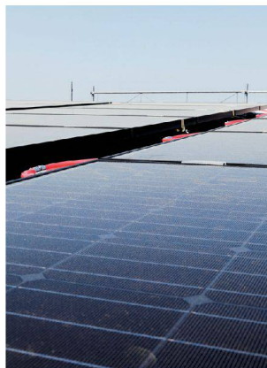
<28 Quadratmeter Hybridkollektoren recken sich auf dem Dach der Sonne entgegen. Sie produzieren Warmwasser und Strom.
