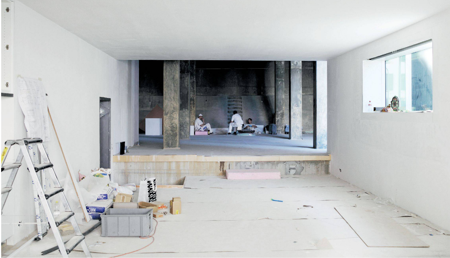
^Blick vom Büro- in den Ausstellungsraum im ehemaligen Wasserreservoir.
