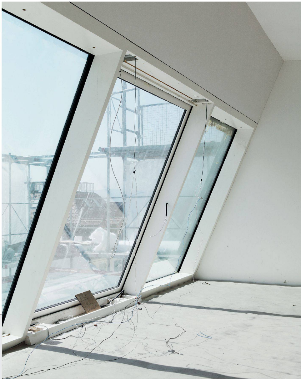
^Konstruktions-Meisterstück: Schrägliegende Schiebefenster im Attikageschoss.
