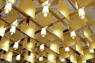
∢Die Platten des Defraktors sind vergoldet. Sie verteilen den Schall.
