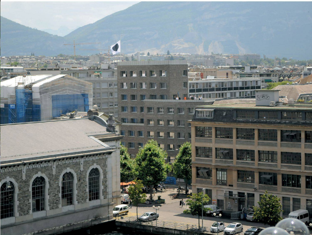
<Pictets bisher grösster Bau: das Studentenwohnhaus an der Rue de la Coulouvrenière in Genf.
