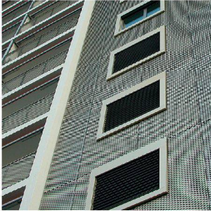
^Geschosshohe Platten aus Streckmetall bilden das Kettenhemd. Foto: Flübacher-Nyfefer + Partner
