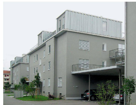
^2_Die Dachaufbauten stärken den Bau, und Unterstände statt Garagen schaffen Durchlässigkeit.
