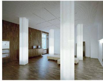
◀ Im Foyer der Kunst- und Archäologiebibliothek in Genf tragen vier Lichtsäulen die Decke.
