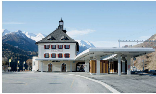
◀ Das Aufnahmegebäude des Bahnhofs Scuol-Tarasp erhielt seine ursprüngliche Farbigkeit zurück und ein neues Dach als Ergänzung.
