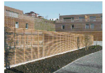
^21_ Die vier Gartenwohnungen und die sechs Attika-Maisonetten sind im Passivhaus-Standard gebaut. Foto: Roos Architekten
