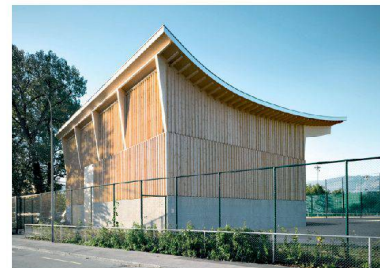
^3b_ Mit der überdimensionierten Höhe und dem fast geschosshohen Betonsockel bietet das Haus Platz für die Giraffen. Foto: Dominik M. Wehrli
