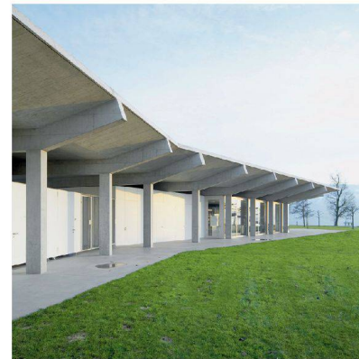
^14_ Kräftige Betonrippen gliedern den Bau in seiner Längsrichtung. Sie setzen die Funktion des Gebäudes als Rückgrat der Anlage bildhaft um. Foto: Roman Keller
