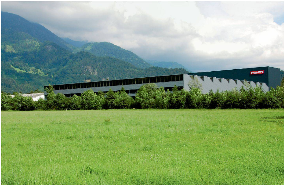
^Die neue Halle vor dem Thüringer Hochregallager. ^The new hall in front of the high rack warehouse in Thüringen.
