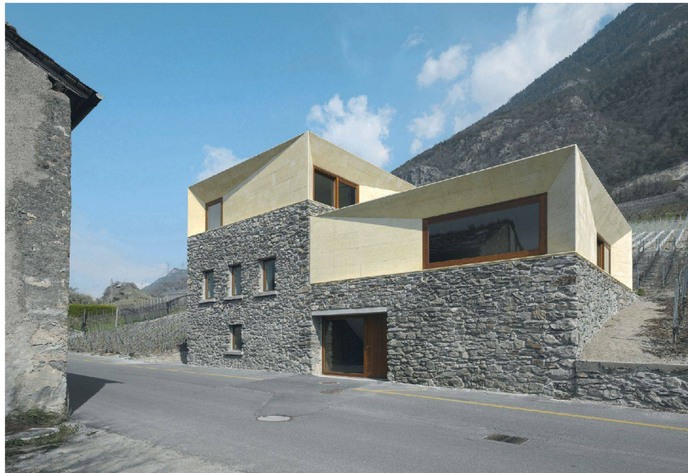
^ Hart an der Strasse in Charrat bei Martigny: Auf den alten Mauern ruhen die Neubauteile aus Beton.
