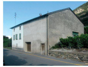
◀ Das Haus im Walliser Dorf Charrat vor dem Umbau.
