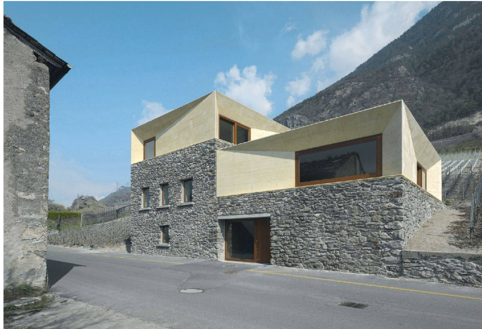
^ Hart an der Strasse in Charrat bei Martigny: Auf den alten Mauern ruhen die Neubauteile aus Beton.
