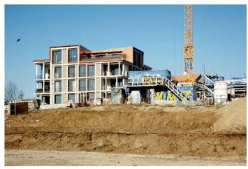
^Der hervortretende Betonraster von «Milano» bindet die Eckloggien in den Baukörper ein.
