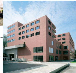
^31_ Wohn- und Geschäftshaus Rotsee.
