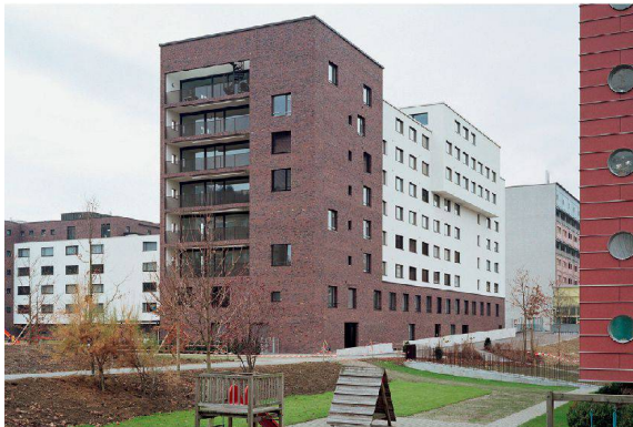
<30_Überbauung Ruopigenhöhe. Foto: Walter Mair
