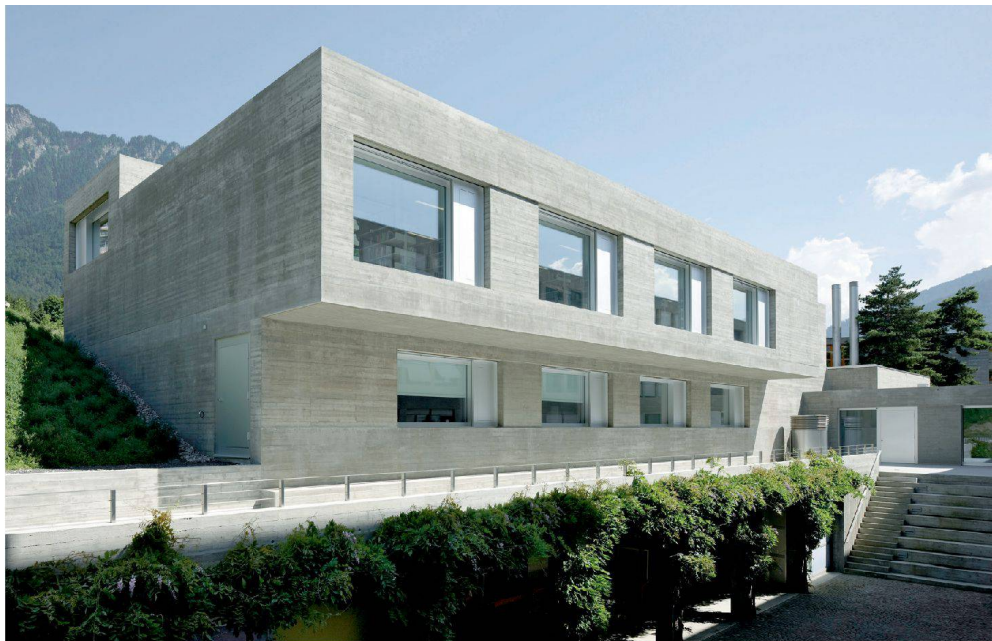
^Ohne Blechdachrand: Im oberen Geschoss der Pädagogischen Hochschule Graubünden in Chur ist die Mediothek, darunter zwei Hörsäle.
