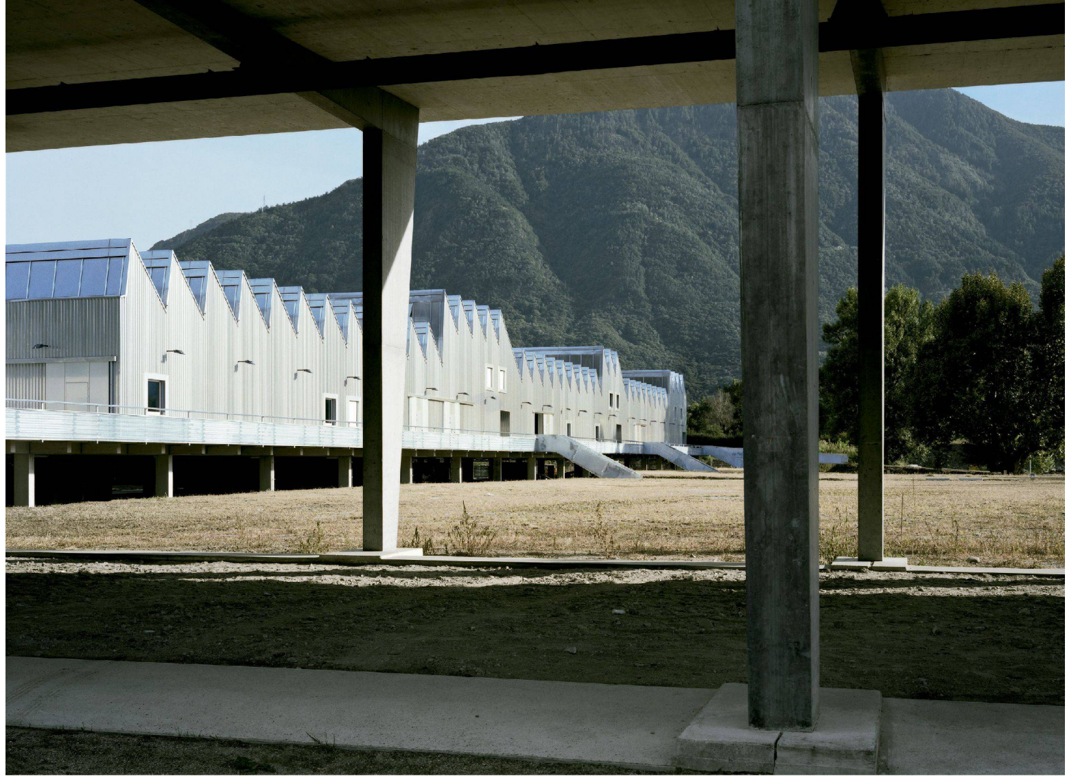
^Die Schule des Baumeisterverbandes in Gordola: ein Shed-Bau auf einer Plattform.
