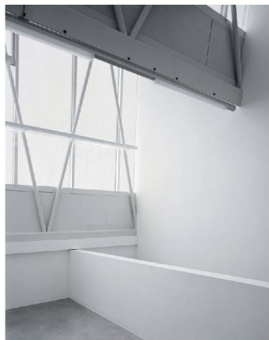
<Die Stahlträger der Sheds tragen auch sämtliche Installationsleitungen.
