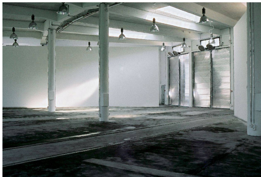
^Neuer alter Ausstellungsraum: Eine neue Wand, ein geflickter Boden, die alten Leuchten. Foto: Katalin Deer
