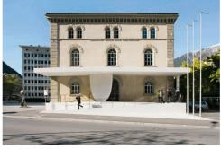
^Kunstwerk aus wenigen Elementen: Postament, Dachscheibe, zwei Stützen, drei Fahnenmasten.
