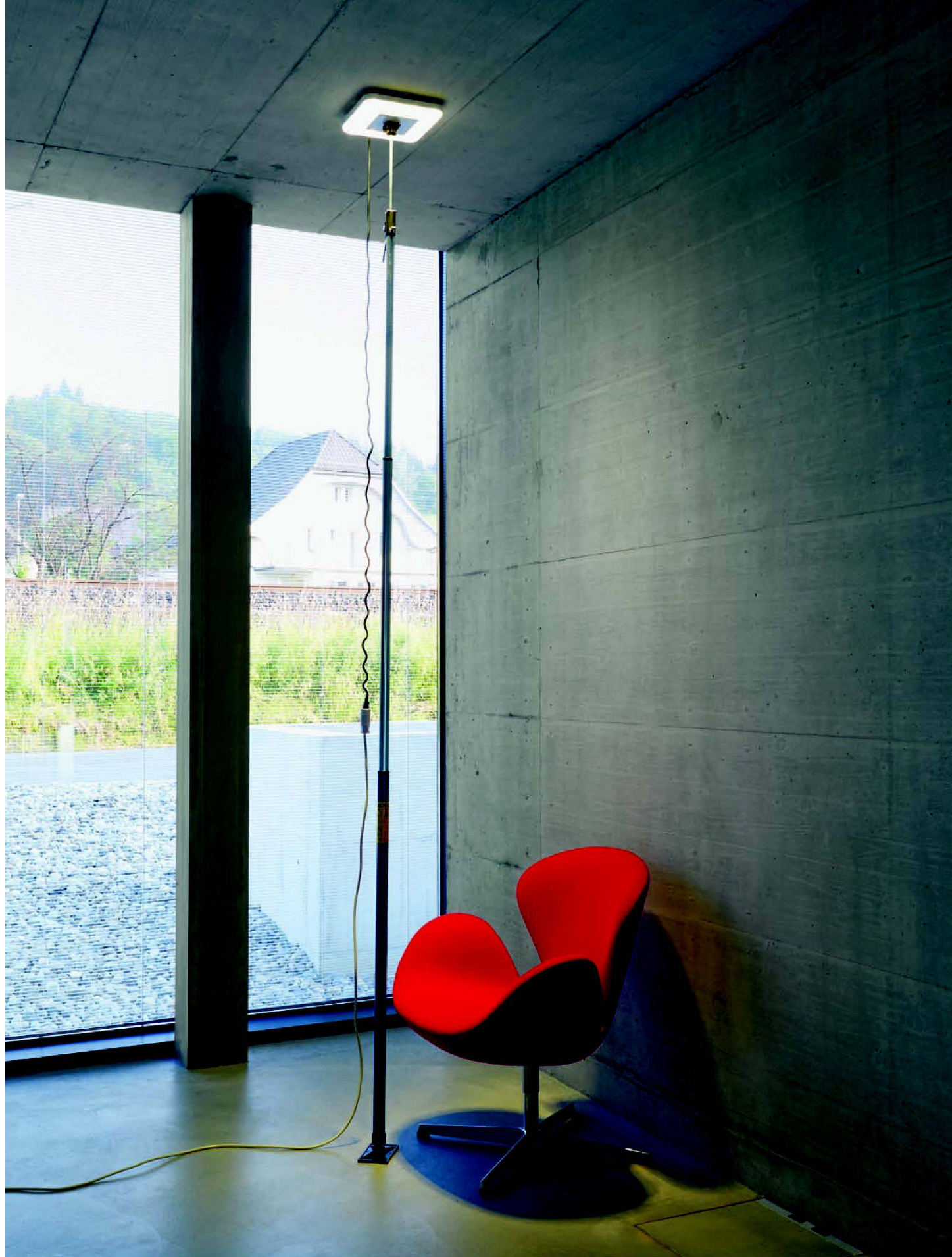
^Die Deckenanbauleuchte «Square» in der Eingangshalle mit einer Hilfsstütze provisorisch installiert.
