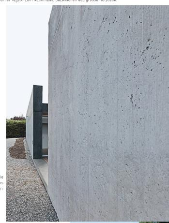
>Misaporbeton KDS heisst die Weiterentwicklung des Dämmbetons mit eingegossener Isolation.
