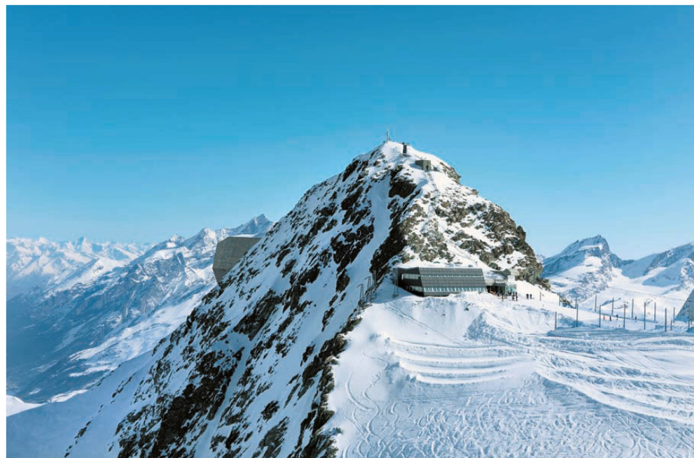
^ Glacier Paradise, 2883 mü. M.: Das Gebäude sonnt seine Fassade und bezieht so seine gesamte Energie.
